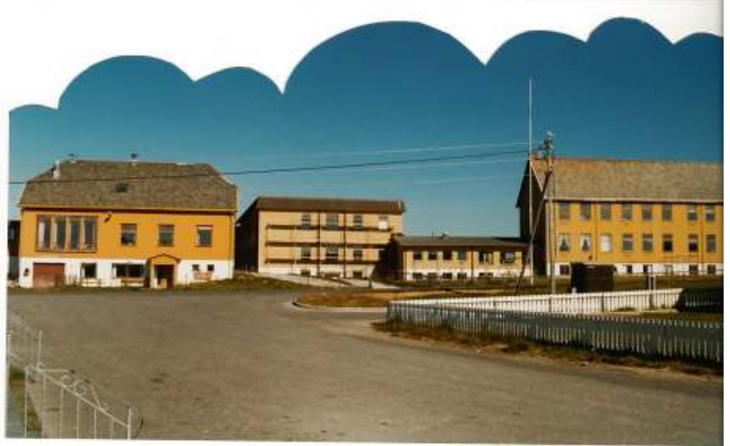
Skoleanlegget på Røst.
